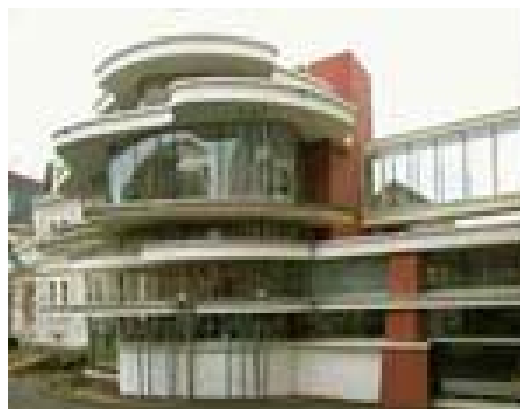
© Malnoury Arrière du bâtiment - Réhabilitation F. Chochon
